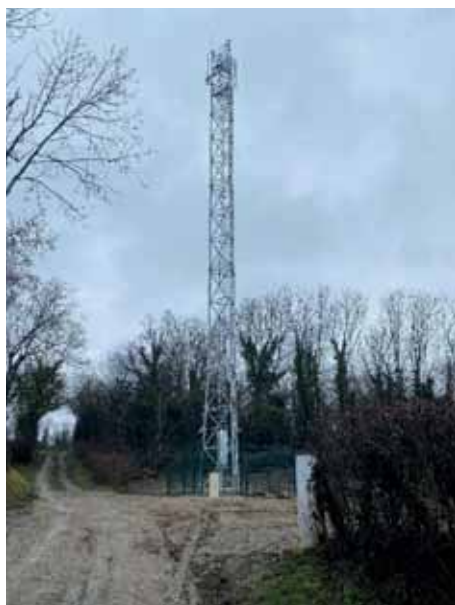
Raccordement électrique du pylône à BORNAY
