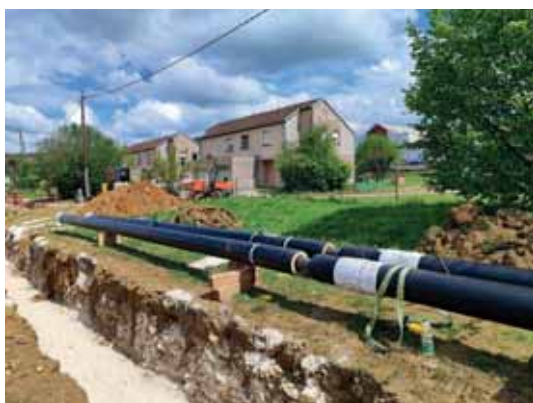
POSE DES TUYAUTERIES DU RÉSEAU
